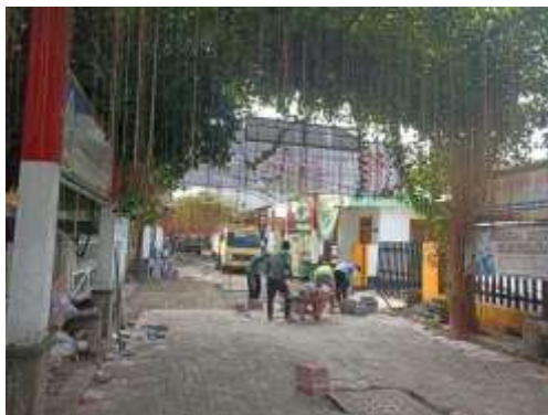
Kegiatan kerja bakti untuk pemasangan paving
