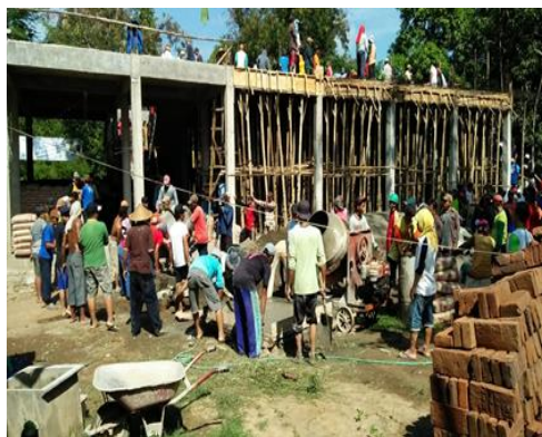
Gotong Royong Renovasi Pembangunan Masjid Wahidiyah
