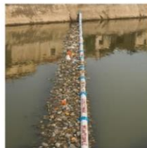
Gambar 2. Penghalang sampah garis vertikal
