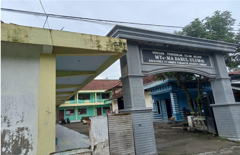
Dokumentasi Pintu Masuk Sekolah
