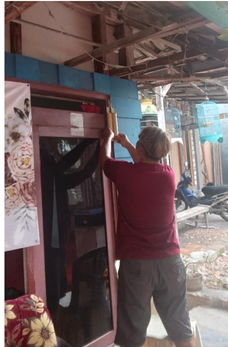
Pemasangan bumbung di sudut rumah
