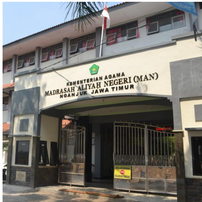
Gedung sekolah tampak dari depan
